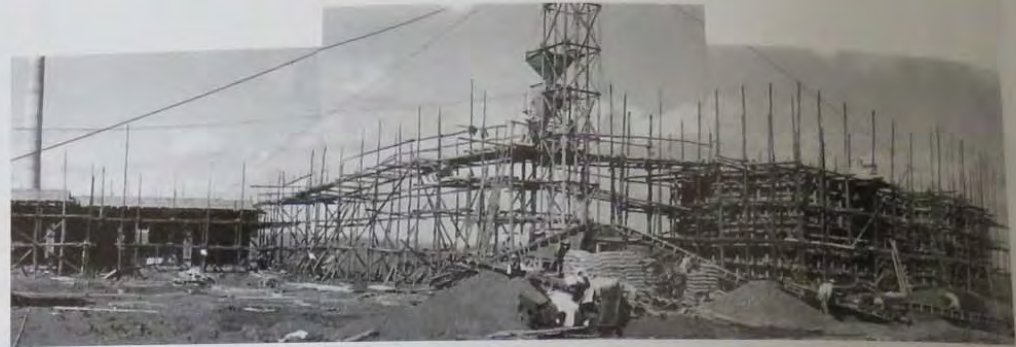
春光台に校舎第1期工事進む
